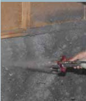
Kit flocage haute pression léger & compact à utiliser avec la TURBISOL pour le flocage de ouate. La pompe s'arrête automatiquement lorsque l'on ferme la vanne d'eau.
